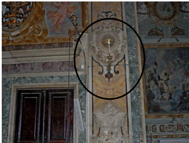
Figura 1 Applique con lampadina a risparmio energetico lungo la navata
